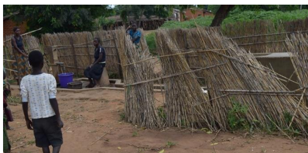
①その 1 グラスフェンス (一部損壊)
