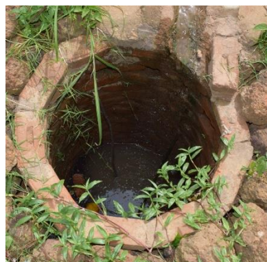
④浸透枡 井戸みtainの(左)と 手入れもされず水が溢れているもの(右)
